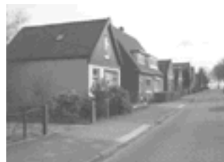
Oosteinde 69: linker zijgevel
