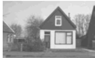
Oosteinde 69: het bestaande huisje zal worden gesloopt
