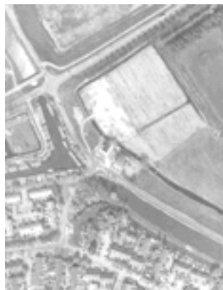
Luchtfoto bouwplaats Zuiderweg 75
