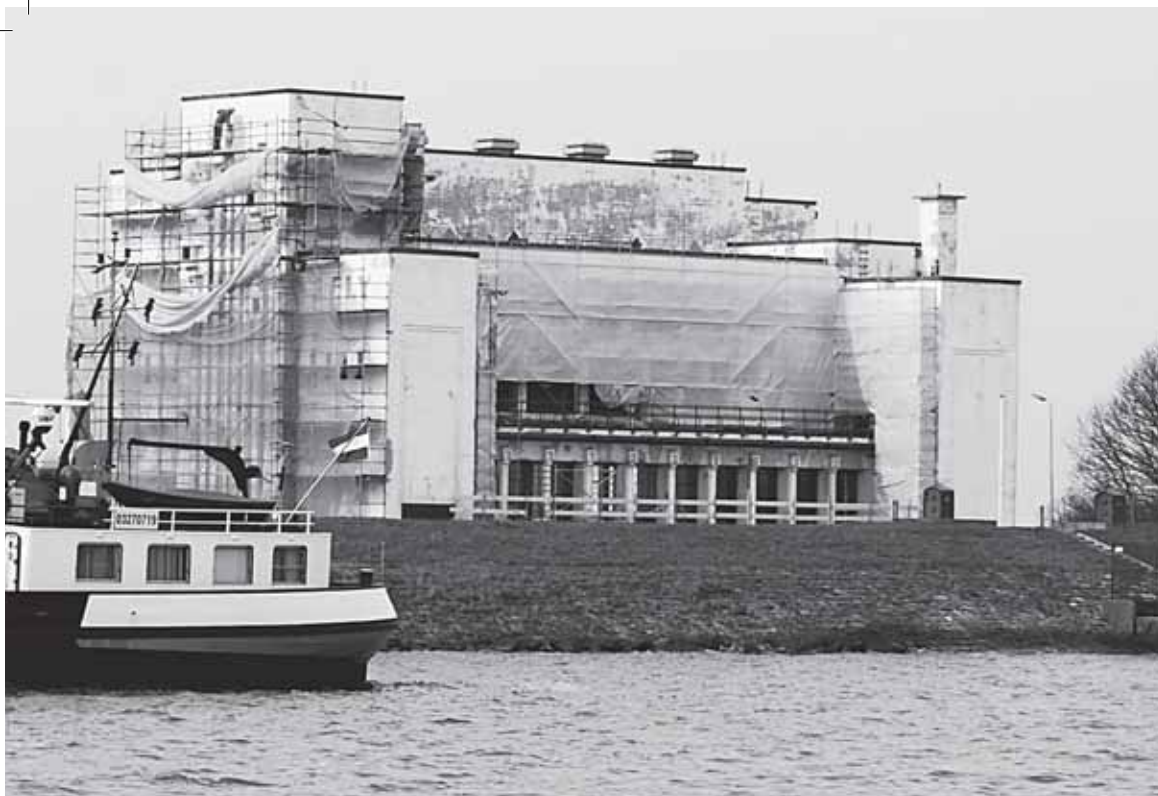
Gemaal Lely ontworpen door Dirk Roosenburg
